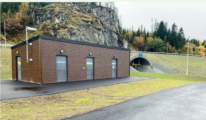
På hver side av Tanemstunnelen er det bygget hus for tekniske installasjoner. Her fra nordsiden.
