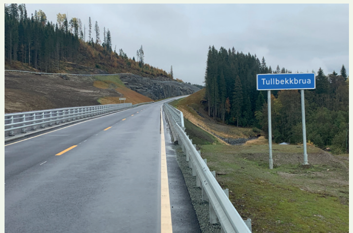
Tullbekkbrua er 92 meter lang.
