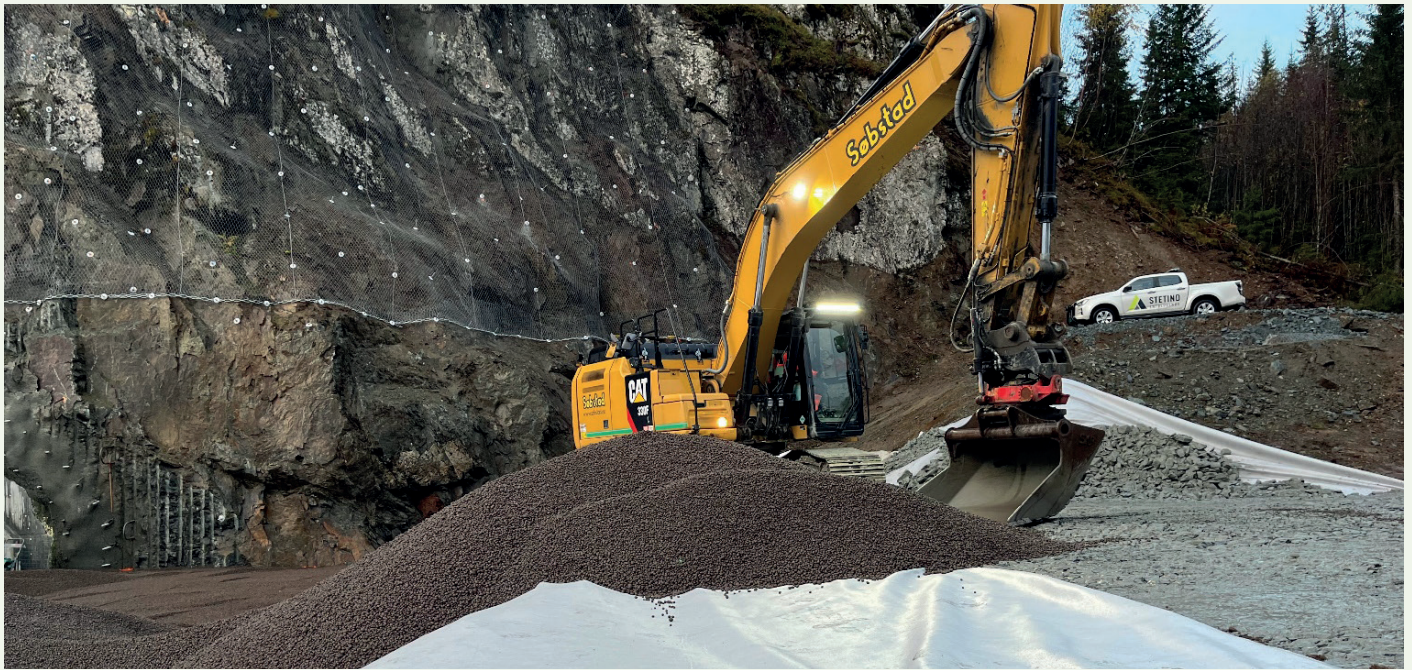
Fjellmasser fra linjen i dagen ble sprengt, knust på plassen og brukt i byggingen av veien.
