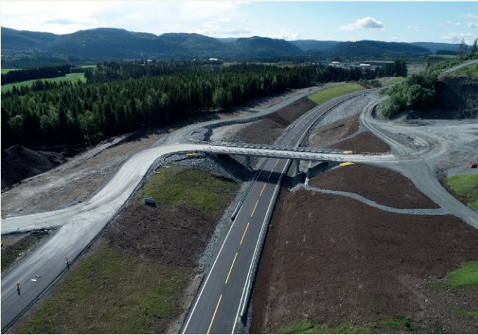
Forsettbrua har en lengde på 43 meter.
