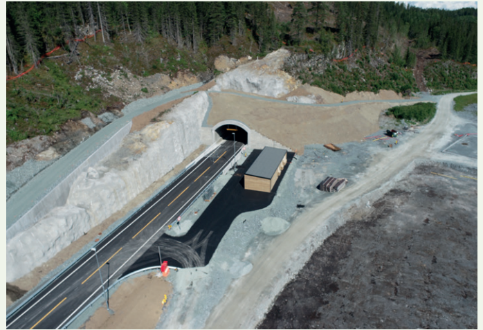
Oversiktsbilde fra sørsiden av Tanemstunnelen.
