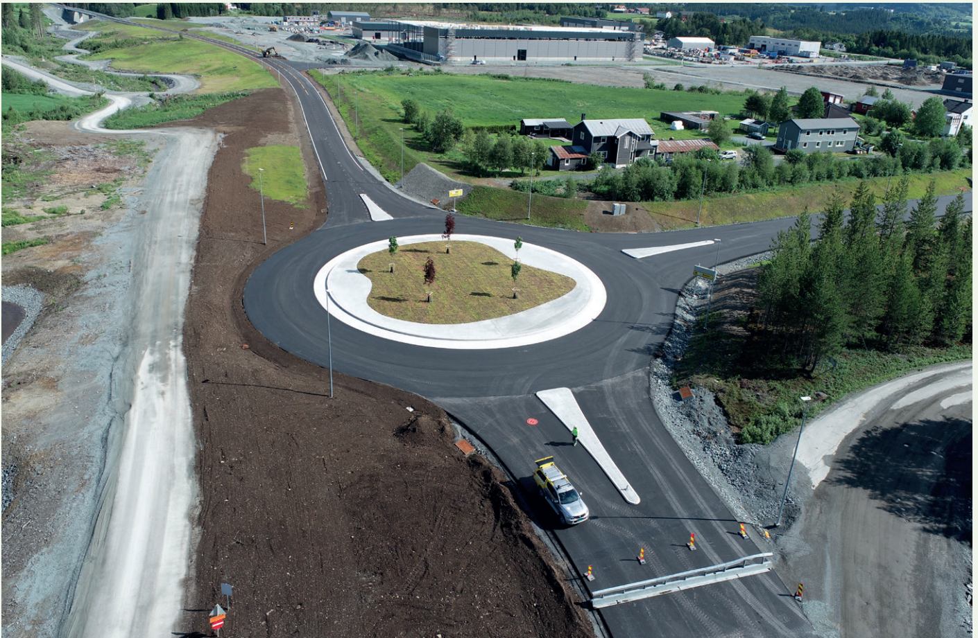
Rundkjøringen er dimensjonert for modulvogntog i henhold til gjeldende håndbøker. Den er også beplantet.
