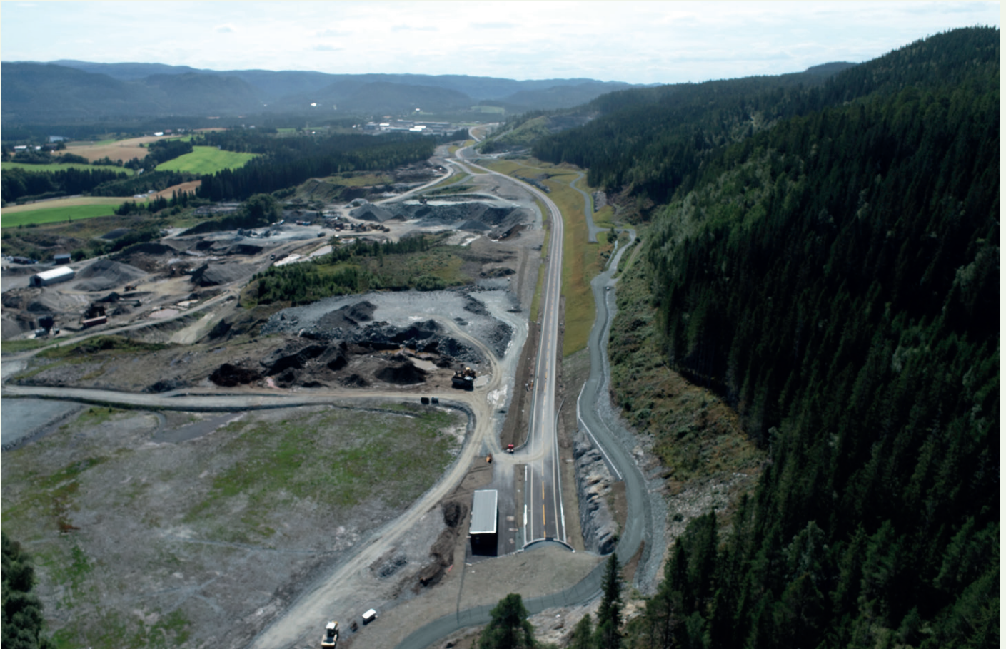
Søbstad AS er hoved entreprenør for den nye traseen på fylkesvei 704.
